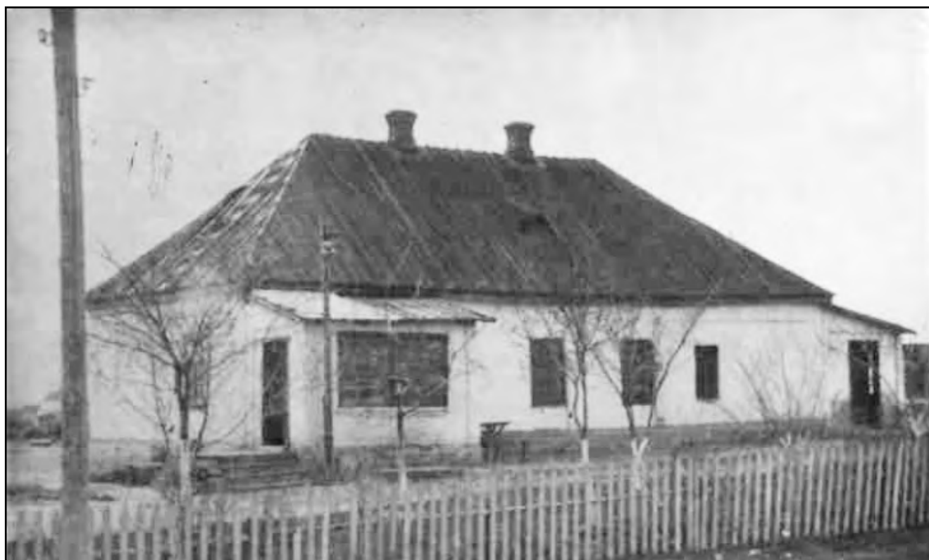
2. Приміщення Веселотернівської початкової школи.
