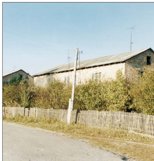
с. Веселе. Двоповерхові будинки
