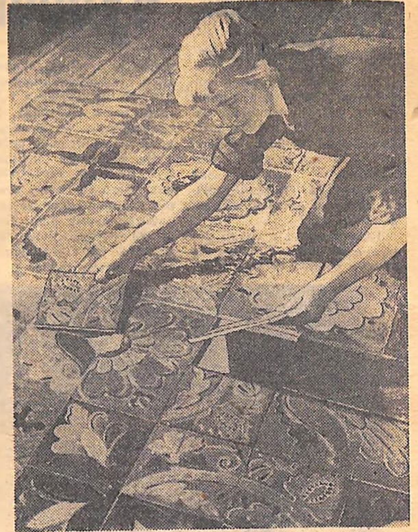
КНІВ. В експериментальній майстерні художньої кераміки науково-дослідного Інституту архітектури споруд Академії будівництва і архітектури УРСР виготовляється декоративні майолікові панно для пілонів підземного вестибюлю станції «Хрещатик» Київського метро.
