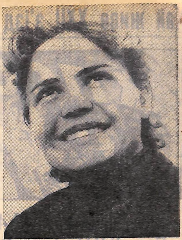
Ганна Андрєєва — чудовий штукатур. Порівняно небагато, трохи більше року, попрацювала дівчина на будівництві Кременчуцької ГЕС, та встигла — багато. Завоювала вона хорошу трудову славу, оштукатурила тисячі квадратних метрів стін в приміщеннях ГЕС. На знімку: Ганна АНДРЕЄВА.
