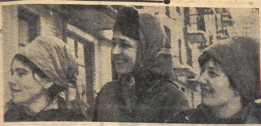
Щоб не запізнилося новосілля — під таким девізом трудяться штатури Будівельного управління № 1 тресту «Кіровоградськбуд» — комсомолки Є. Гамбург, К. Степанова та Р. Кучеренко. Скоро вони подарують кіровоградцям 129-квартирний будинок по вулиці П. Поповича.
