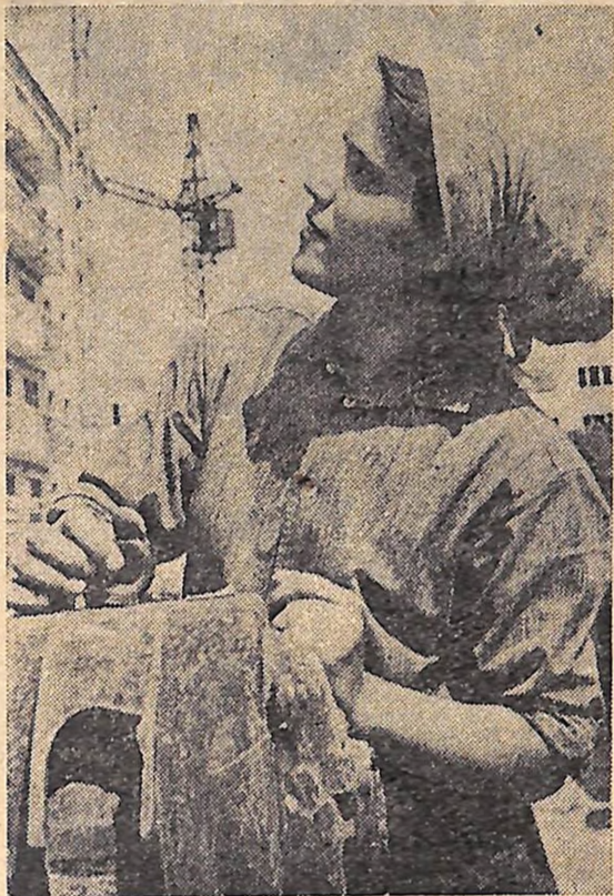
На вулиці Жовтневій міста Олександрії споруджуються п'ятиповерхові житлові будинки. Там трудиться мотористка будівельних машин комсомолка Любов Абдула з третього будівельного управління тресту «Кіровоград-вуглебуд».
