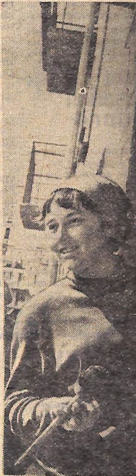
Молодіє і кращає наш Кіровоград. То будівельники роблять його таким. Серед них — і комсомолка Світлана Корсун. У бригаду майянів-штукатурів першого будівельного управління тресту «Кіровоградпромбуд» вона прийшла після закінчення профтехучилища. Сьогодні Світлана не лише майстер своєї справи, а й член комсомольського комітету тресту, баскетболїстка товариства «Авангард».
