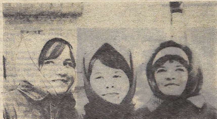
На привокзальній площі міста Знаменки виростає 100-квартирний житловий будинок. В числі будівельників — комсомолки (зліва направо): Марія Гудієнко, Лідія Горобень і Марія Царалунга. Щомісяця дівчата виконують план на 115-117 процентів. Фото Б. ВИТОХІНА.
