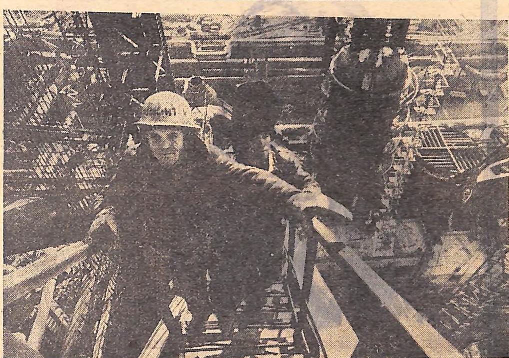
ІА ЗНІМКУ: монтажники Микола ГРАЦІОВ і Олександр КОСТИКОВ працюють на будівництві третьої домної печі Західно-Сибірського металургійного заводу. Фото Е. ЕТТІНГЕРА. АПН.
