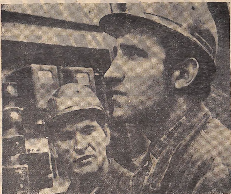
Вже в позаминулому місяці спецуправління № 411 тресту «Дніпроелектромонтажбуд» задало в експлуатацію трансформаторну станцію. Прискорювали цю подію комсомольці Петро МОВЧАНІЙ і Едуард РАЧНИНСЬКИЙ.
