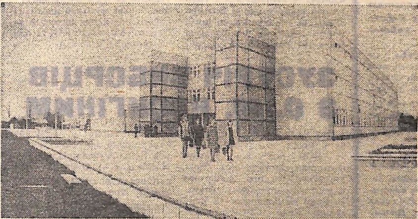
Івано-Франківська область. У селищі Богородчани одночасно з спорудженням газопроводу «Союз» угорські спеціалісти збудували за своїм проєктом школу на 800 чоловік. Це — сучасний будинок. У його спорудженні використані збірні залізобетонні конструкції, скло і легкі метали. Кабінети, спортзал, їдальня та інші приміщення сплановані і обладнані з врахуванням сучасних вимог педагогіки, застосування технологічних засобів навчання, раціонального використання навчального часу і площі.
