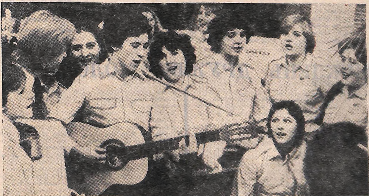
НА ЗНІМКУ: БІЙЦІ СТУДЕНТСЬКОГО БУДІВЕЛЬНОГО ЗАГОНУ «МРІЙНИК» КІРОВОГРАДСЬКОГО ДЕРЖАВНОГО ПЕДАГОГІЧНОГО ІНСТИТУТУ ІМЕНІ О. С. ПУШКІНА.
