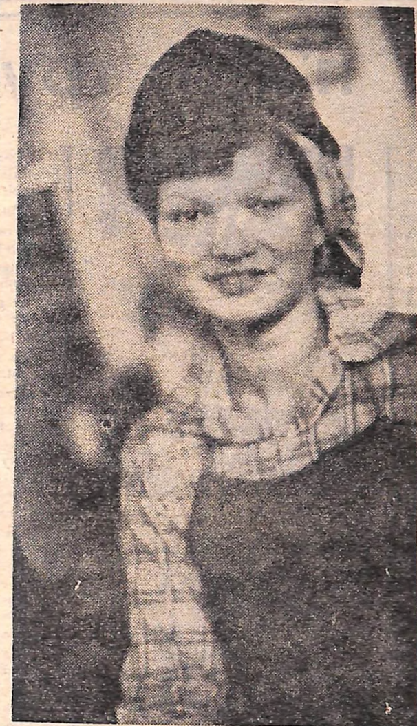
На знімку: молода електрозварювальниця Світловодського заводу конструкцій швидко монтажних будівель Наталка БОНДАРЕНКО.
