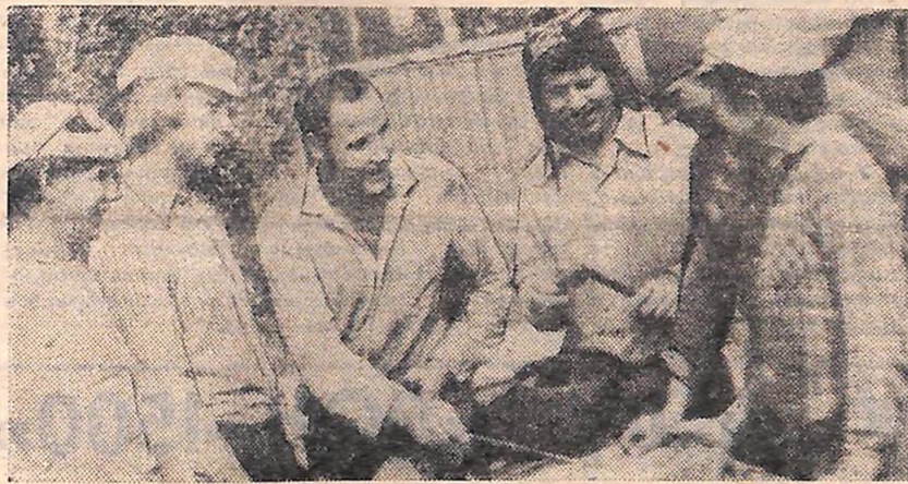
Комсомольсько-молодіжна бригада електрозварників Д. Т. Пахомова (на знімку) — одна з кращих на Світловодському заводі металокопирцій. Зараз бригада вийшла на перше місце серед комсомольсько-молодіжних колективів виробничого об'єднання «Дніпроенергобудіндустрія».
