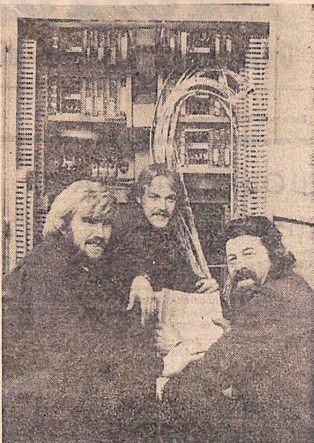
На Тамбовській ділянці газопроводу споруджена газоконденсаторна станція «Староюр'ївська». На її зведенні працювали молодіжні підрозділи будівельників з НДР.
