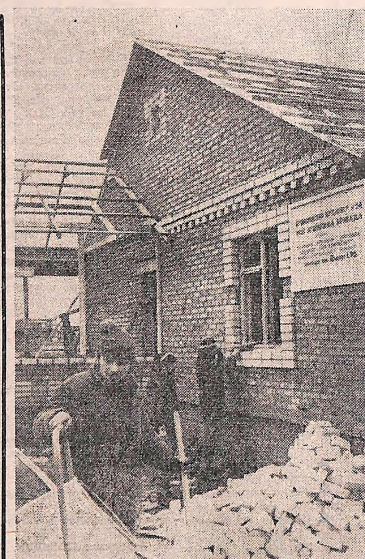
Загін будівельників Кіровоградського облгосбуду споруджує у селі Василівці Ставищенського району Київської області 60 будиноків для евакуйованих із зони Чорнобильської АЕС.
