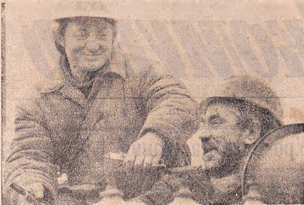
Всім років здійснює ремонт повітряних ліній Юрій ТНАЧЕНКО (зліва), який разом з електромонтером-кабельником Олександром ГРИШИНИМ трудиться на Кіровоградській міській електромережі. Судячи з відгуків їхніх колег, працюють вони якісно і оперативно.
