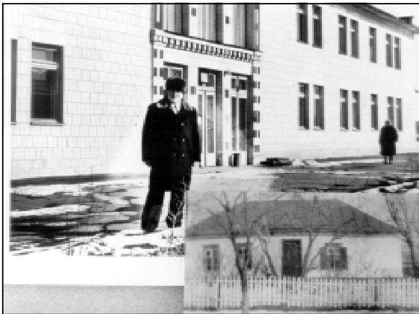
1989 рік. Інфекційне відділення Маловисківської центральної райлікарні і старе приміщення інфекційного відділення.
