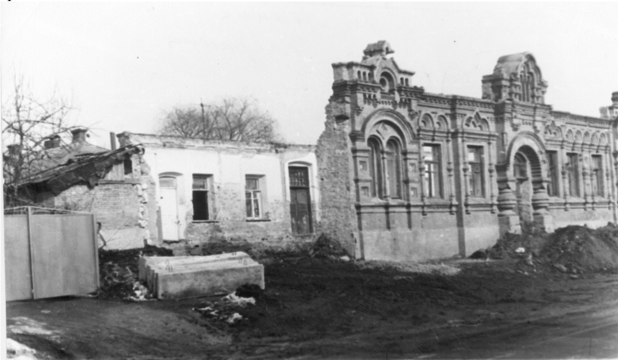
Стан будинку на початок його реконструкції
