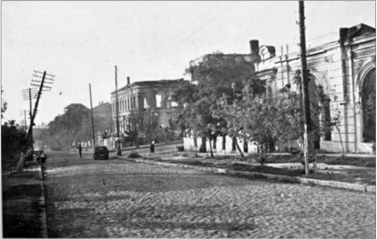
Зруйновані будівлі на перехресті вулиць К. Маркса (Великої) та Шевченка (фотограф стояв на вул. Шевченка спиною до вул. Компанійця (Пашутінської), ліворуч від нього – місце, де знаходяться сучасні будівлі стоматологічної та дитячої поліклінік, 1941 [130].
