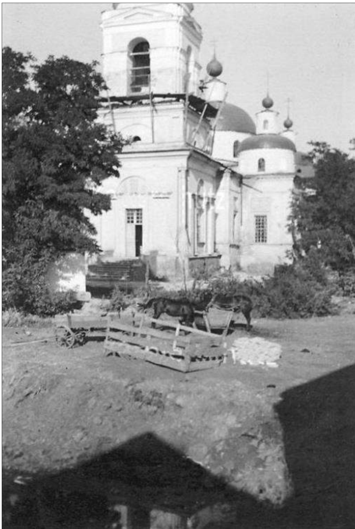
Ремонтні роботи на дзвіниці Спасо-Преображенського собору, 1942. Із колекції Ігоря Світецького.
