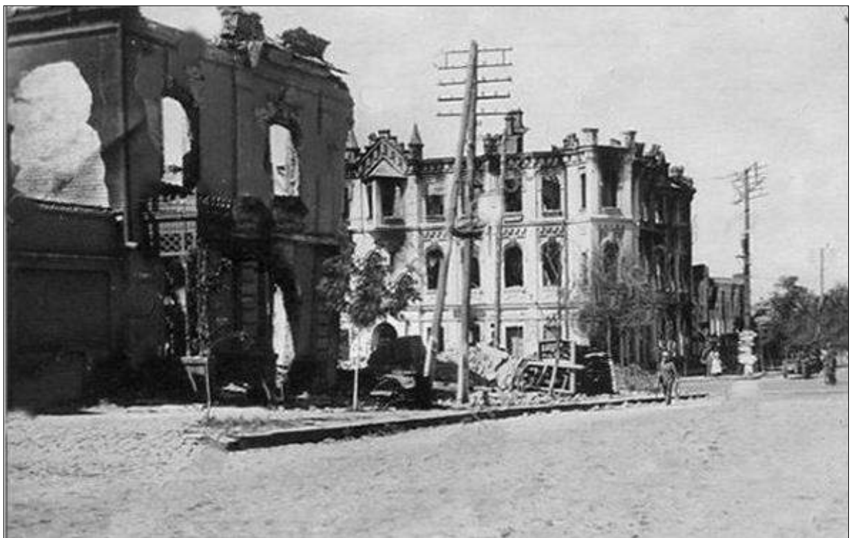
Перехрестя вулиць Т. Шевченка та К. Маркса, серпень 1941. Ліворуч – будівля фармацевтичного складу, у центрі – будівля готелю [130].
