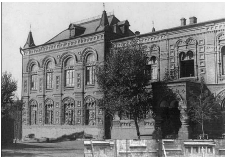
Будівля комендатури, що була розташована в приміщенні школи на вул. Вокзальній (Ковалівка), 1942.
