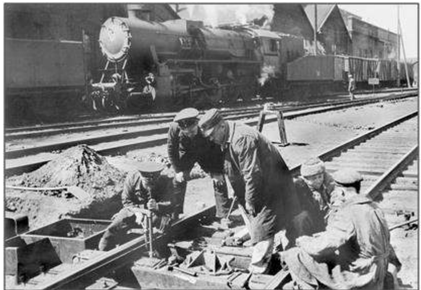
Ремонт ручного перемикача на станції Знам'янка, 1943. Фото Вальтера Холлнагеля.
