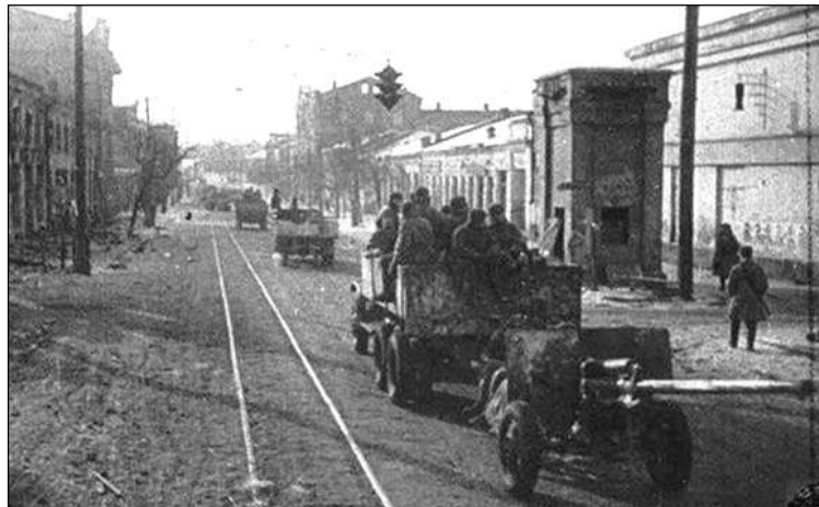
Трансформаторна будка на вул. К. Маркса, 1944 [31]
