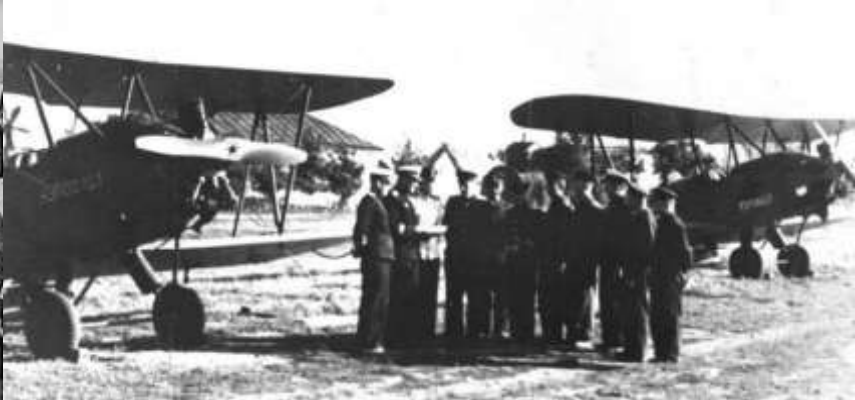
Літаки ПО-2, обладнані баками 200-250 кг хімікалій та пристроєм для їхнього розсіювання під фюзеляжем, 1952 [73]
