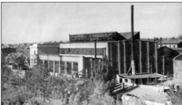
Новий корпус заводу «Червона зірка», 1932 (із фондів ДАКО)
