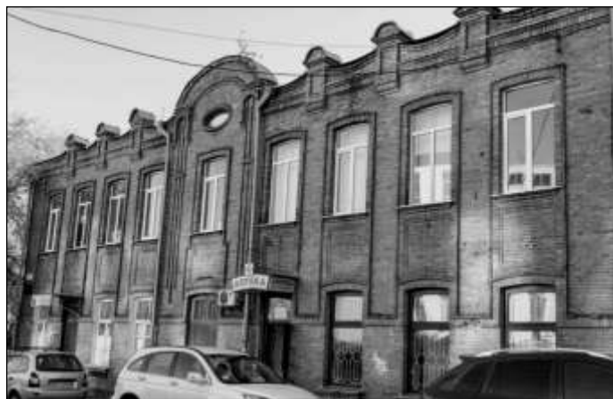
Будинок на вул. Верхній Биківській (Чапаєва) ) [57]
