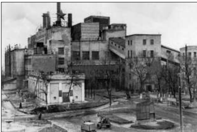
Зінов'євська районна електростанція, 1934 (ДАКО)
